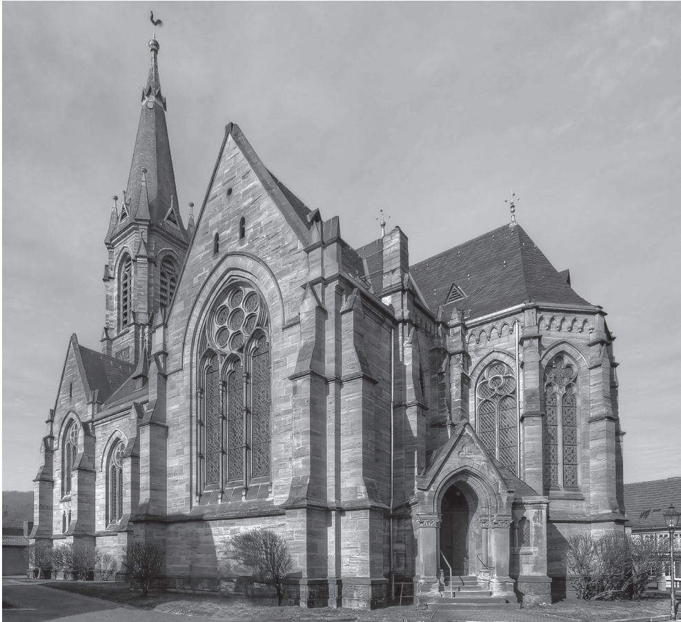
Abb. 3: Ev. Kirche in Wanfried, außen von Südost [Jürgen Katzer ( https://commons.wikimedia.org/wiki/File:Wanfried,ev.Kirche_20110223_112832.jpg ), retuschiert, https://creativecommons.org/licenses/by-sa/4.0/legalcode ]
