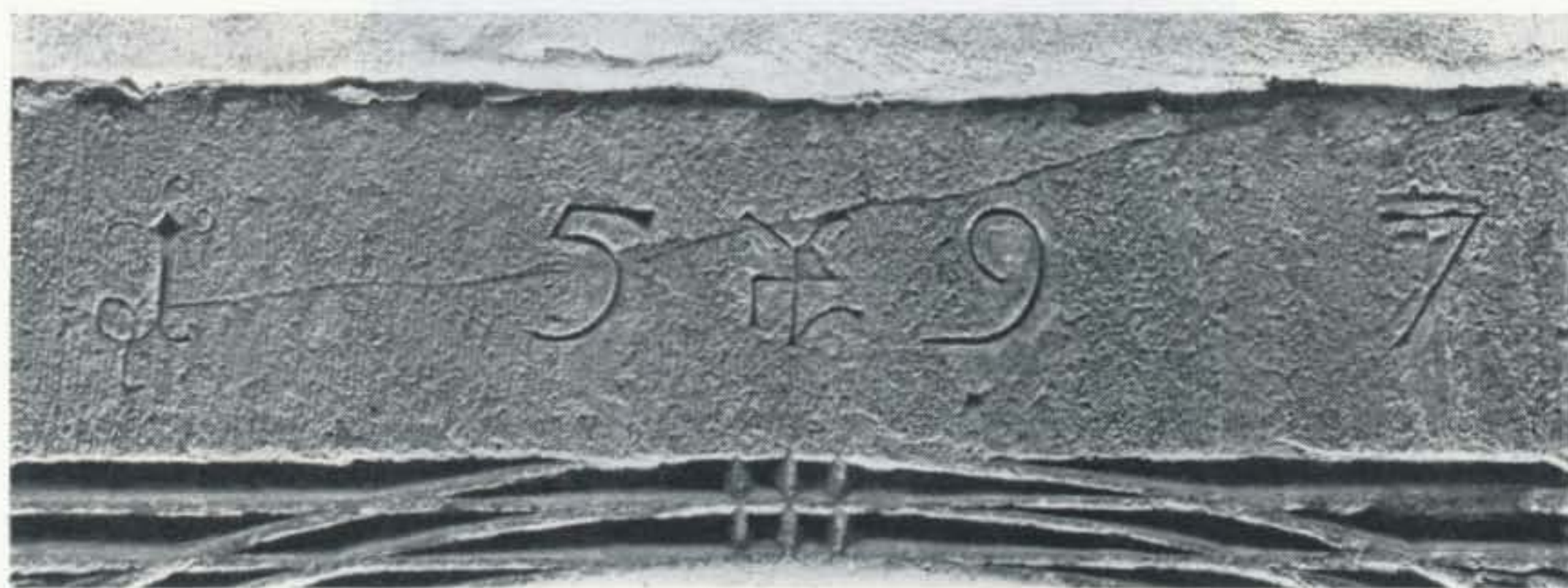
Abbildung 128 Türsturz am ehemaligen Stadtknechtshaus in Büdingen, heute Rathausgasse 4, mit dem Steinmetzzeichen des Jost Scherff, 1597
