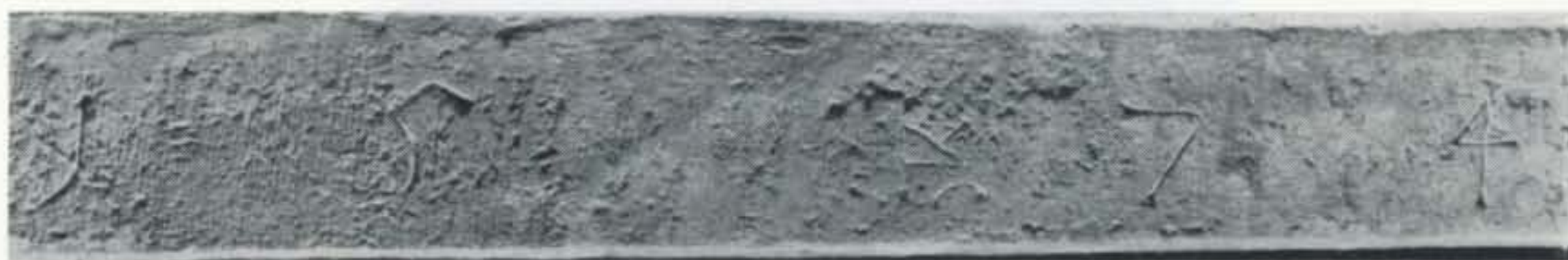
Abbildung 127 Türsturz an der Hofseite des Ysenburgischen Hauses der Burg zu Staden mit dem Steinmetzzeichen des Jost Scherff, 1574
