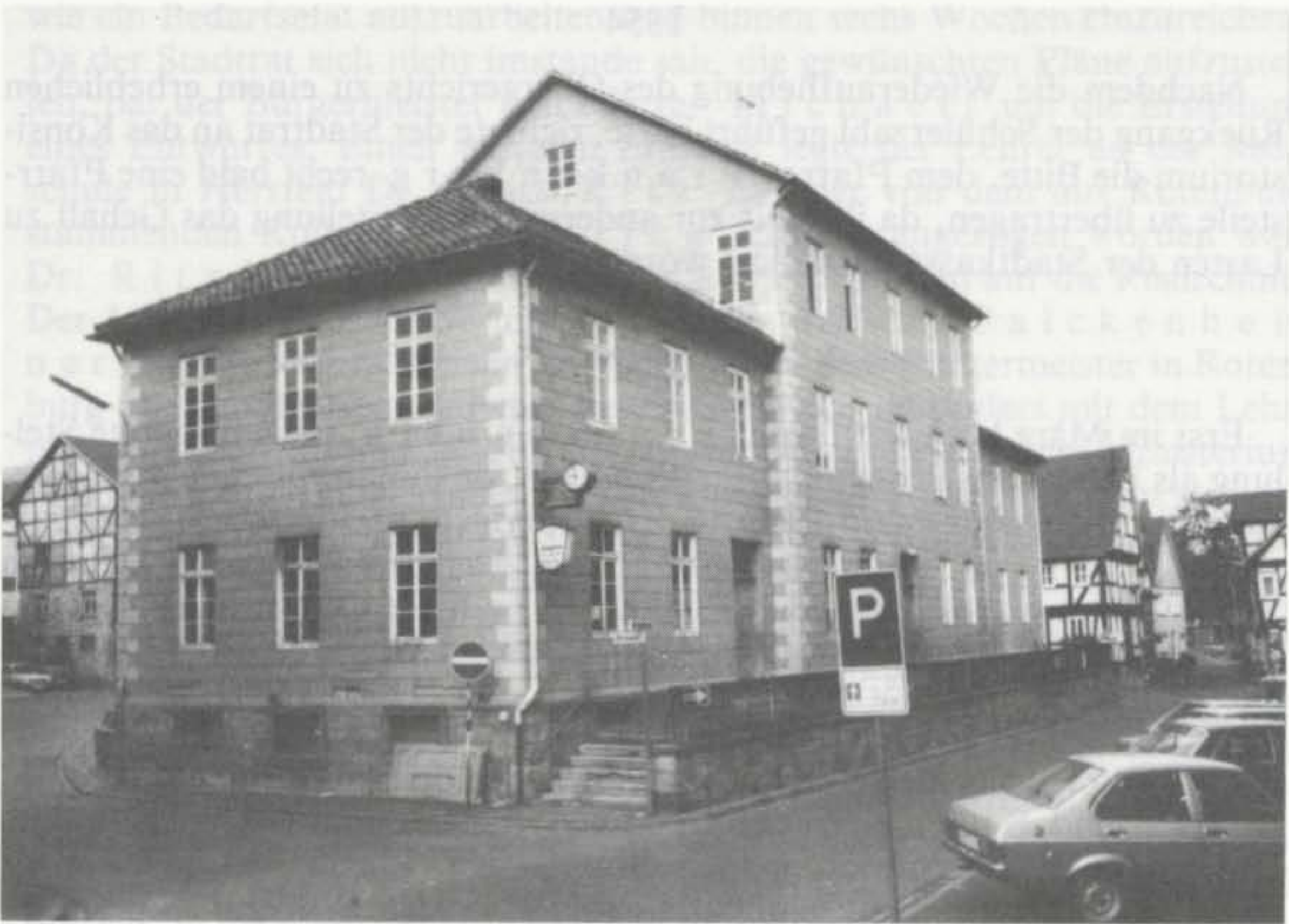
Rotenburg/Fulda „Gelbe Schule“ frühere Höhere Bürgerschule. Foto 1979 vor dem Abbruch
