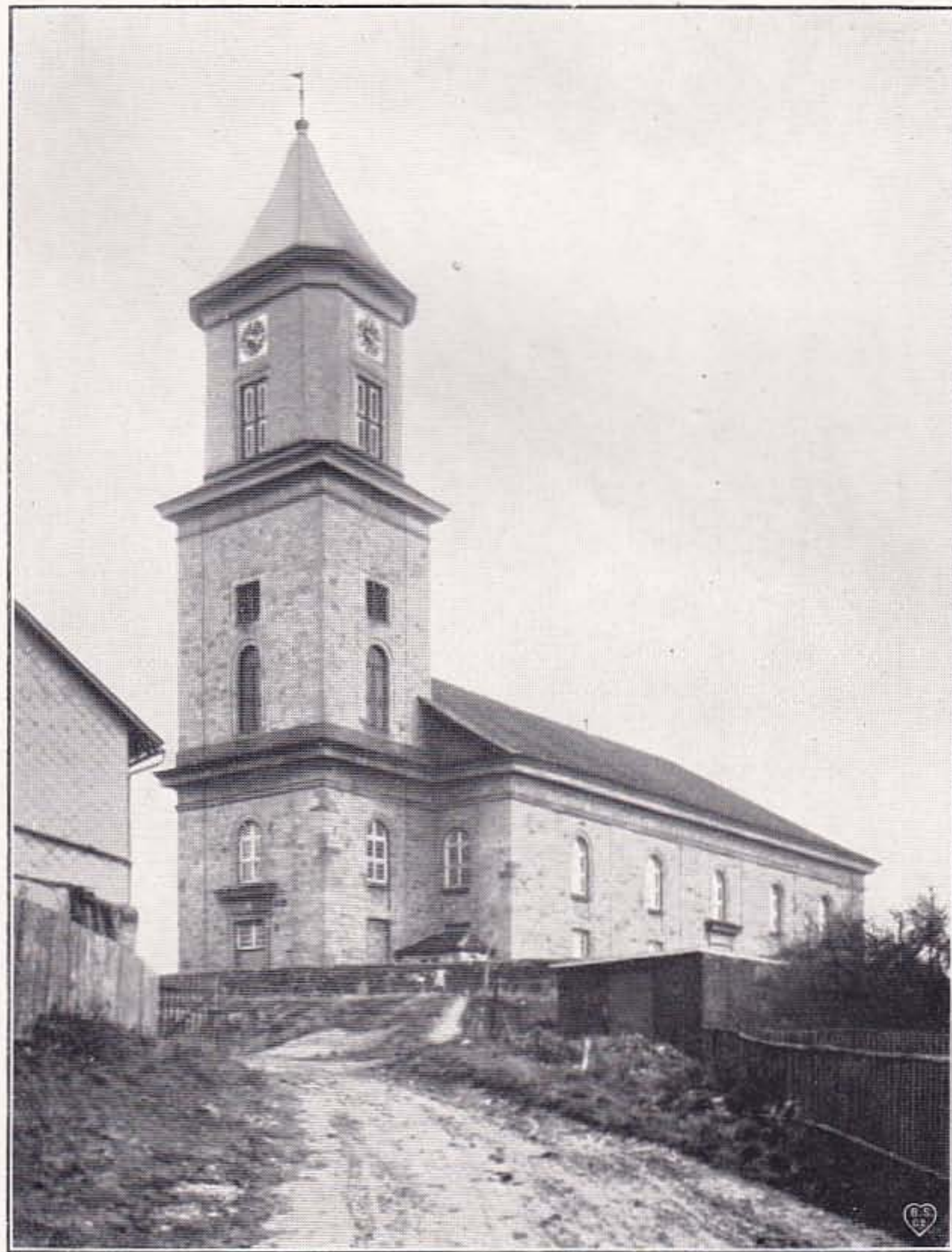
2. Kirche zu Kirchditmold. Neue Anlage, nach Erneuerung des Turmhelmes.
