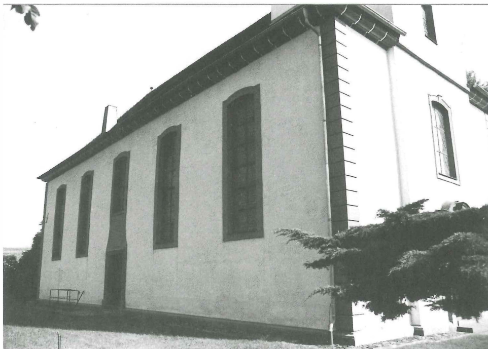
Abb. 10: Äußeres der Kirche Oberweimar von Nordwesten. Aufnahme 1995 (Foto: Bamberger).
