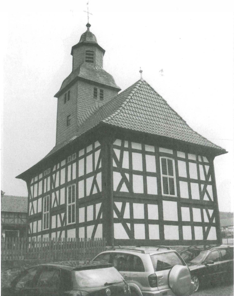
Abb. 5: Äußeres der Kapelle Allna von Nordwesten. Aufnahme 2006 (Foto: Bamberger)
