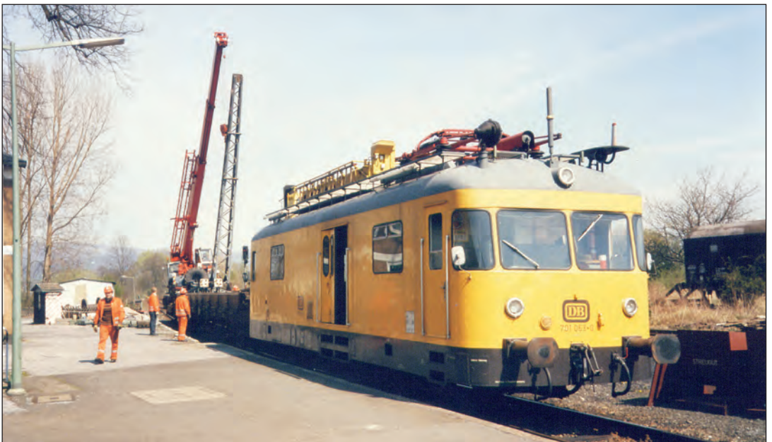
Beim Abbau der Fahrleitungsmasten am 21. 04. 1990 kam auch der TVT zum Einsatz
