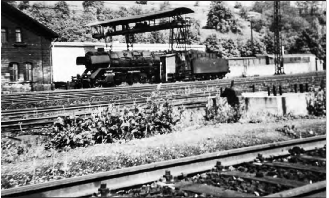
45-er Lok v. Bw. Minden 1966 (Friedatunnel!)
