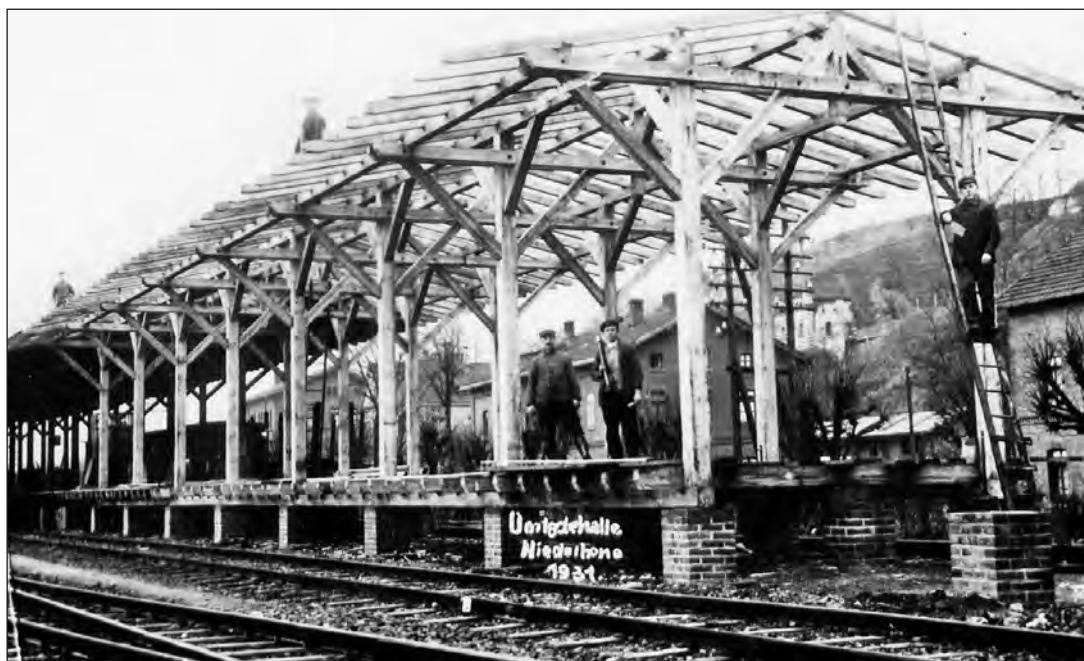
Die Umladehalle am Bahnhof Niederhone im Bau, 1931
