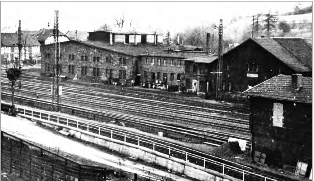
Die beiden Lokschuppen in den 60-er Jahren, zwischen den Gebäuden befand sich die Lokleitung sowie die Personalräume vom Lokpersonal.
