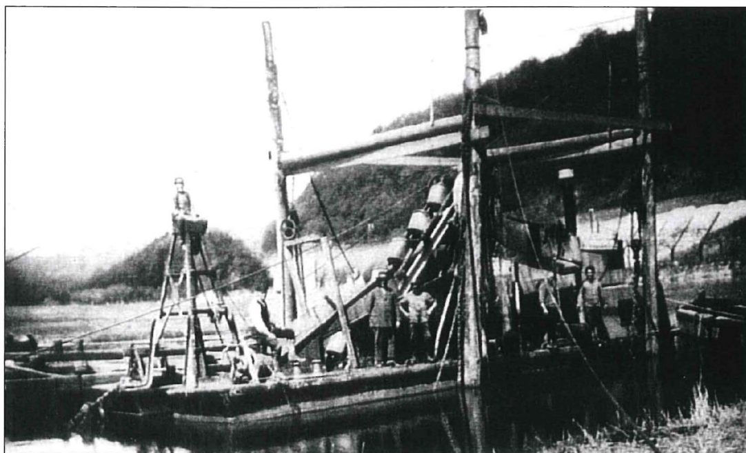
Einer der ersten dampfbetriebenen Eimerketten-Schwimmbagger der Fa. A. O. Oppermann auf der Werra im Jahre 1925.
