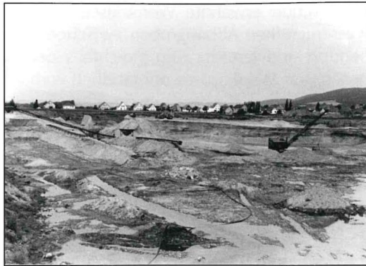
Kiesgewinnung im Trockenabbau nördlich der B 249 bei Eschwege (im Hintergrund Grebendorf). Dieser Bereich ist weitgehend durch Fremdverkipfung niveaugleich verfüllt und heute mit gewerblichen Einrichtungen bebaut.
