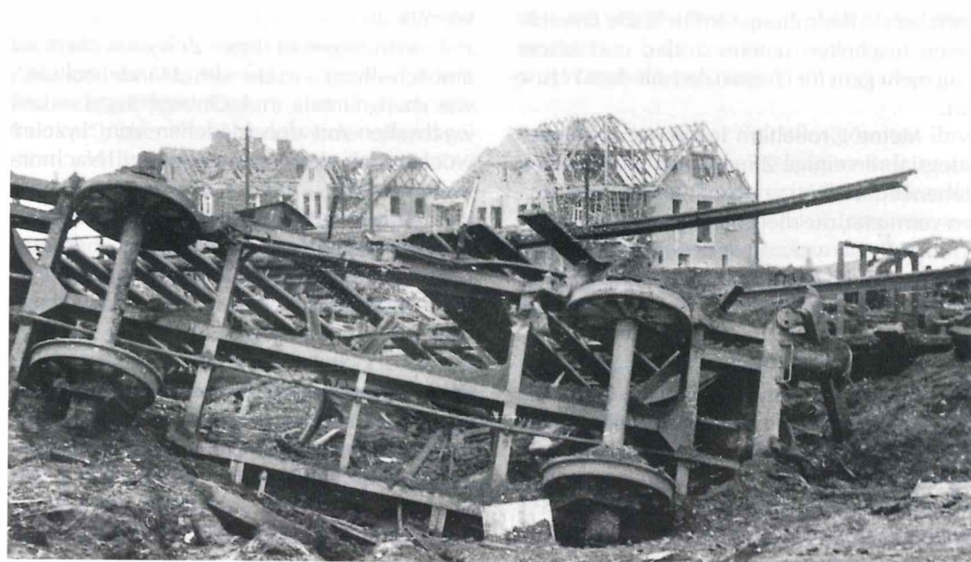
Abb. 3: Folgen des Bombenangriffs vom 22.2.1945 auf das Bahngelände in Eschwege.
