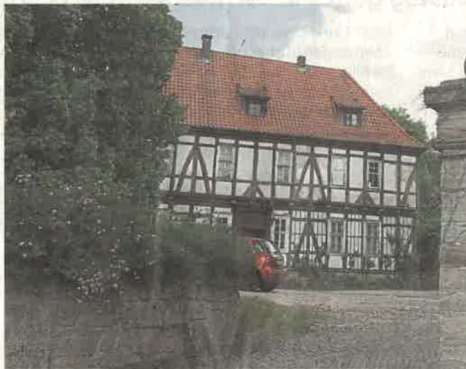
Das Elternhaus der Sophie von Baumbach stammt aus der Mitte des 17. Jahrhunderts und ist Teil eines Gutshofs mit mehreren Gebäuden.
